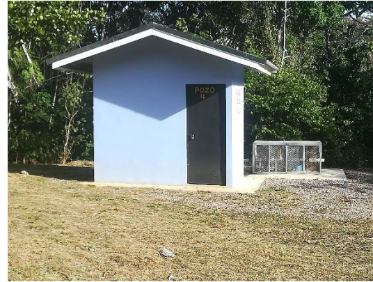
Pozo #4 La Cabriola
